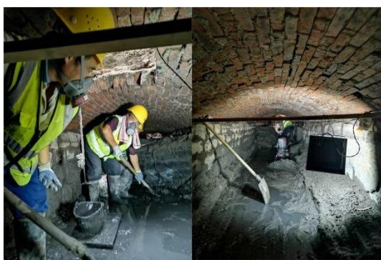
玉带河清淤、疏通及风貌整治
