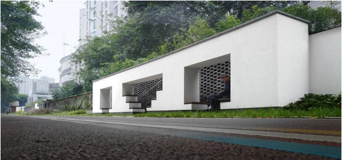
(5) 围墙及建筑外墙粉刷效果
